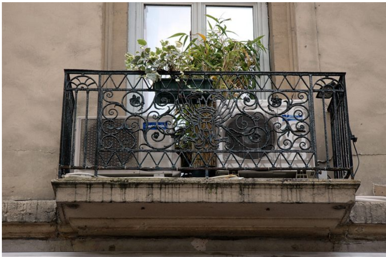
Lotissement : 12 rue d'Amboise, détail du garde-corps du balcon provenant de l'ancienne commanderie des Antonins de Lyon
