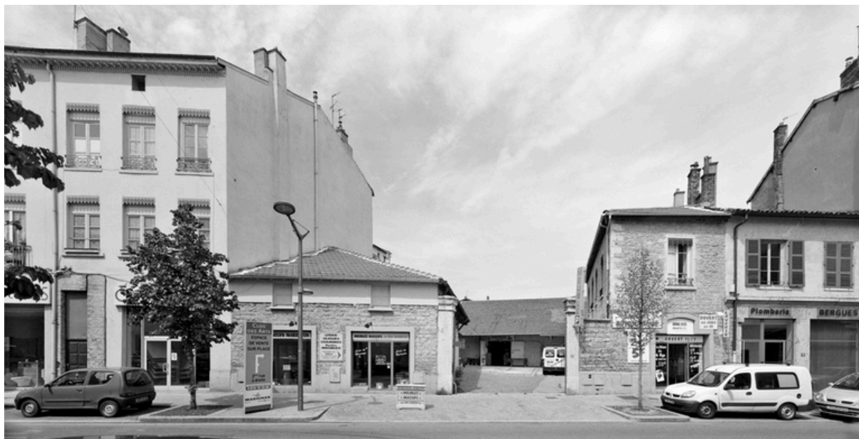
Vue générale sud-est
