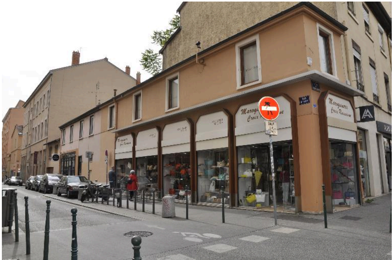
Vue d'ensemble nord ouest
