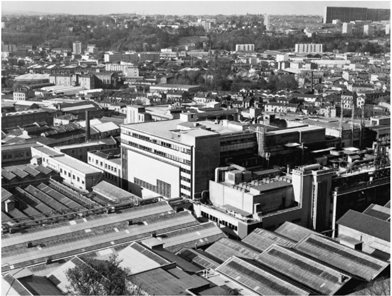
Vue ouest du site
