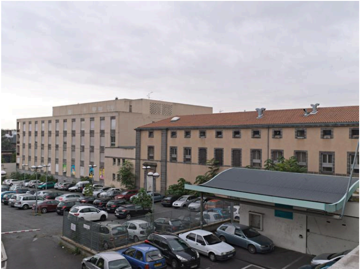
Hôtel-Dieu de Clermont-Ferrand. Le Refuge et le bâtiment de gastro-entérologie vus du nord-ouest.
