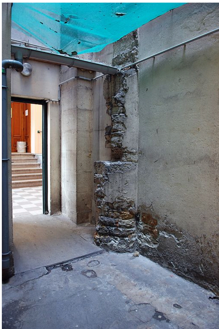
Vue de la cour depuis mur ouest.
