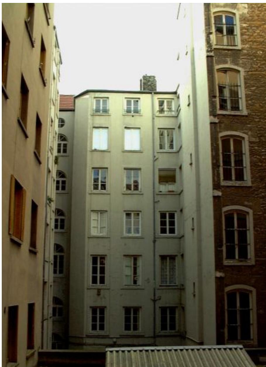
Elévation postérieure et travée d'escalier
