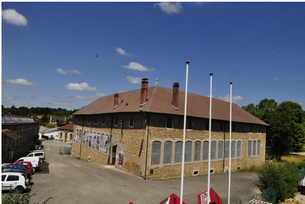
Vue extérieure de la forge
