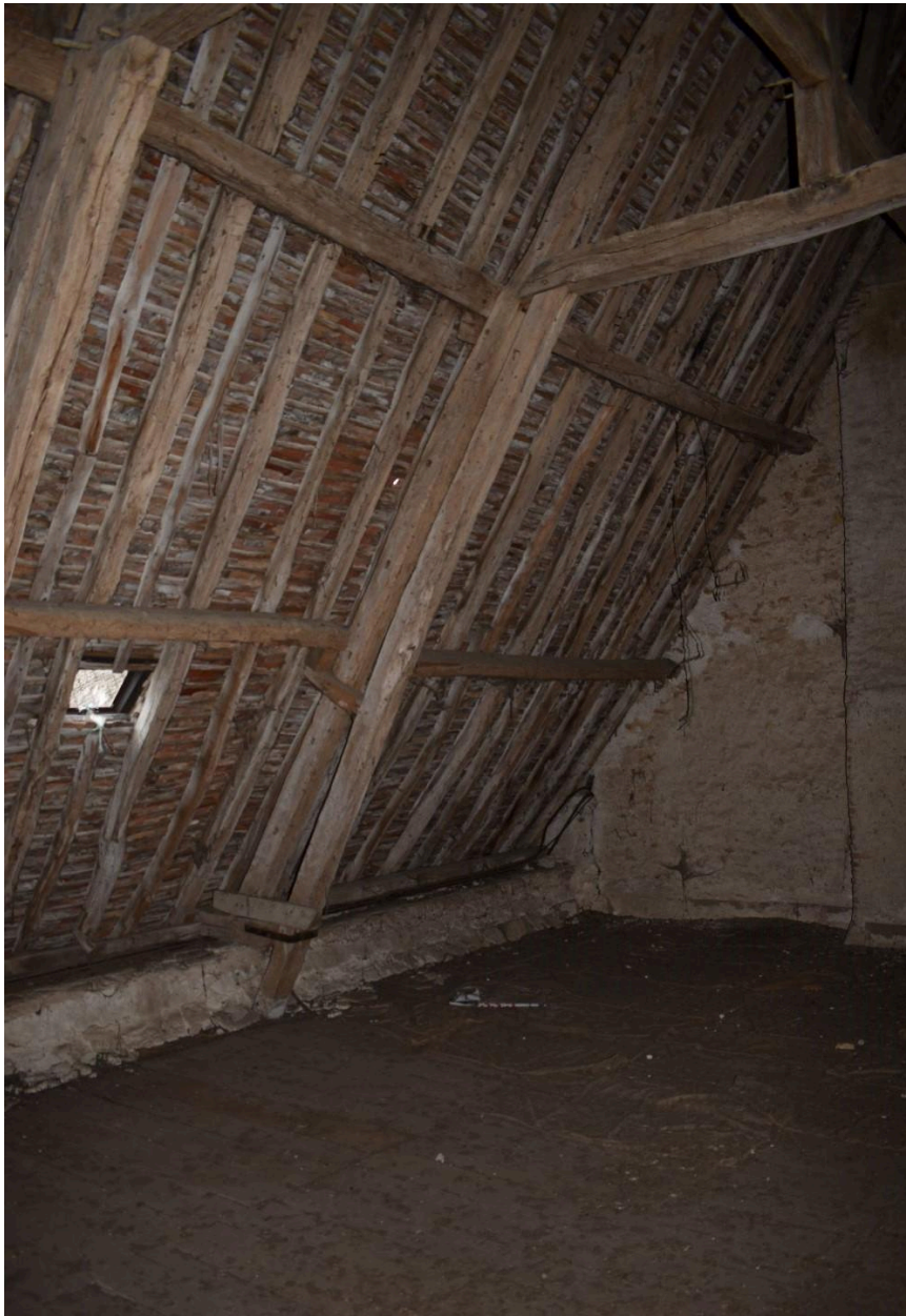
Vue de la charpente de l'ancien logis
