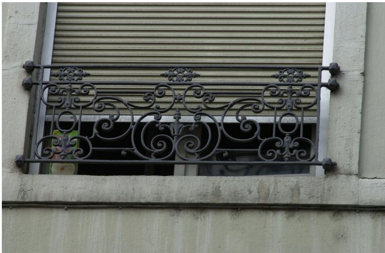
Détail d'un garde-corps
