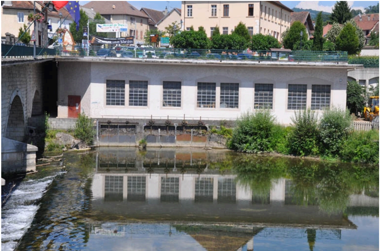
Vue de la prise d'eau avec trois vannes le long de la rivière du Guiers
