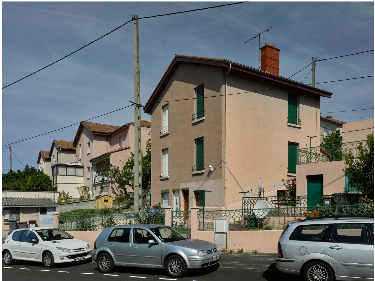
Maisons dans la partie sud-est de la cité, au croisement de l'allée des Côtes-de-Chanturgue (vers le n° 17) avec la rue Simon-Wiesenthal.
