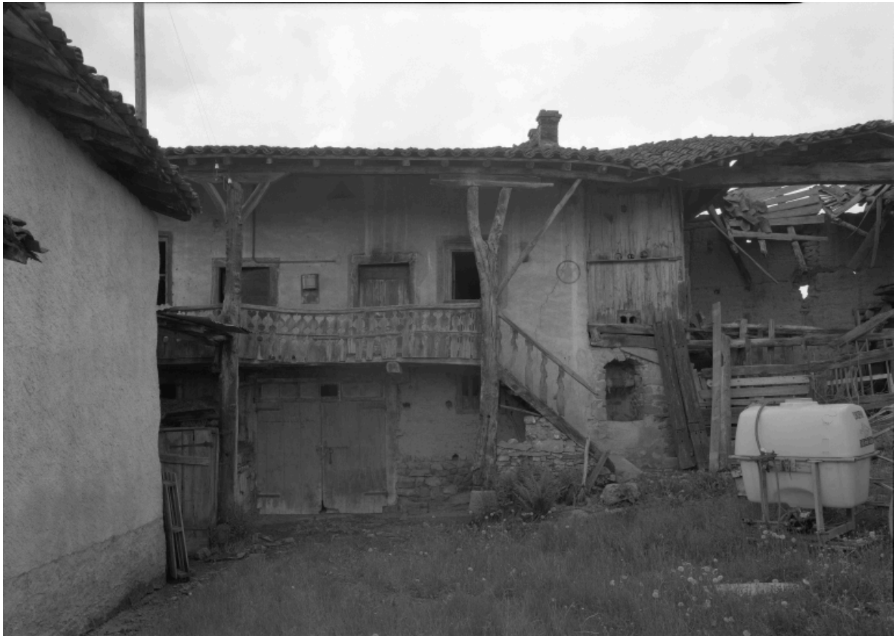
Vue d'ensemble du logis ancien de face.
