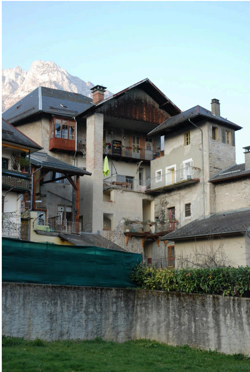
Vue des élévations postérieures, depuis le sud-ouest.
