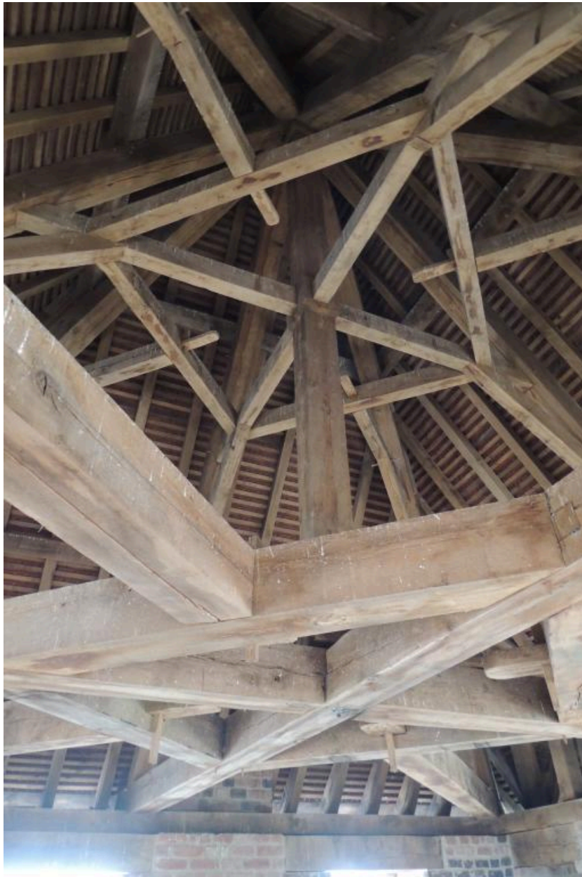
Donjon : intérieur, niveau 4, la charpente.
