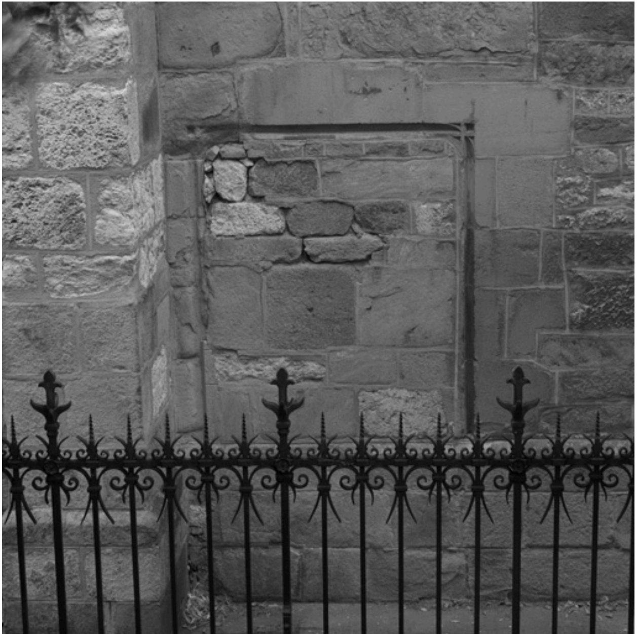
Élévation sud : détail de la porte murée (travée IV).
