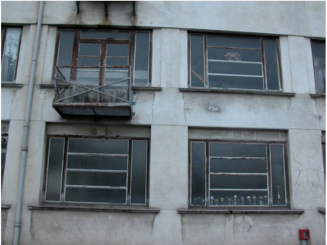
Détail de baies de l'élévation nord de l'aile nord de l'église.
