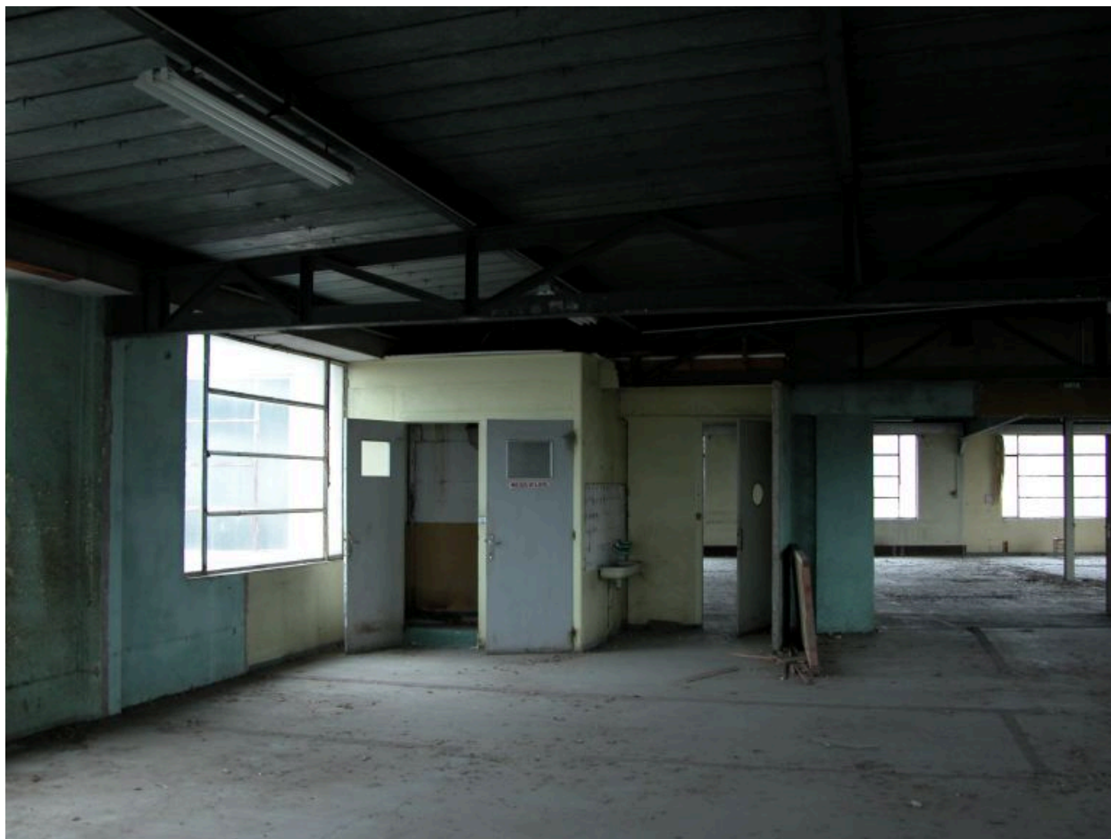
Sanitaires de l'aile nord de l'usine.
