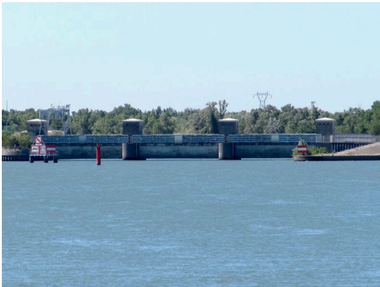
Barrage amont : vue générale, face amont
