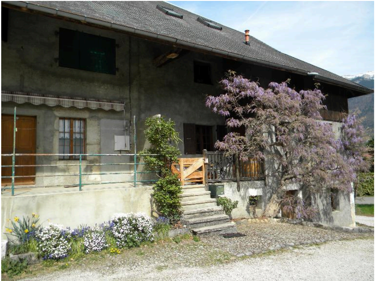
Vue de la partie habitation en facade sud.
