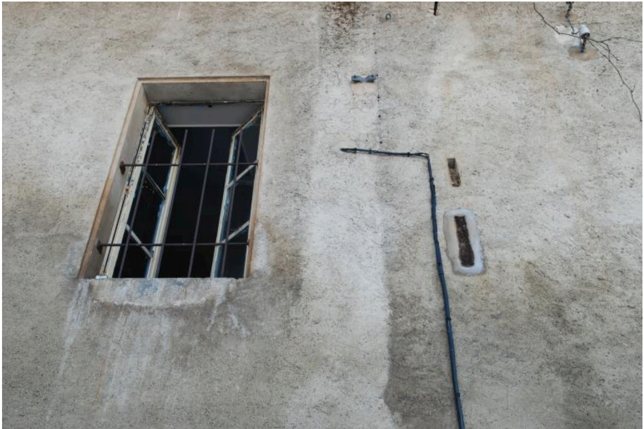
Façade arrière, détail d'ouvertures dont un petit jour vertical de placard "réfrigéré".
