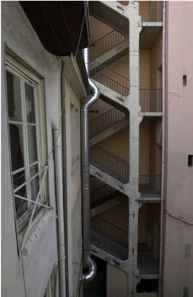
Vue d'ensemble de la cage d'escalier depuis le nord (escalier du 12 Grande rue de la Guillotière)
