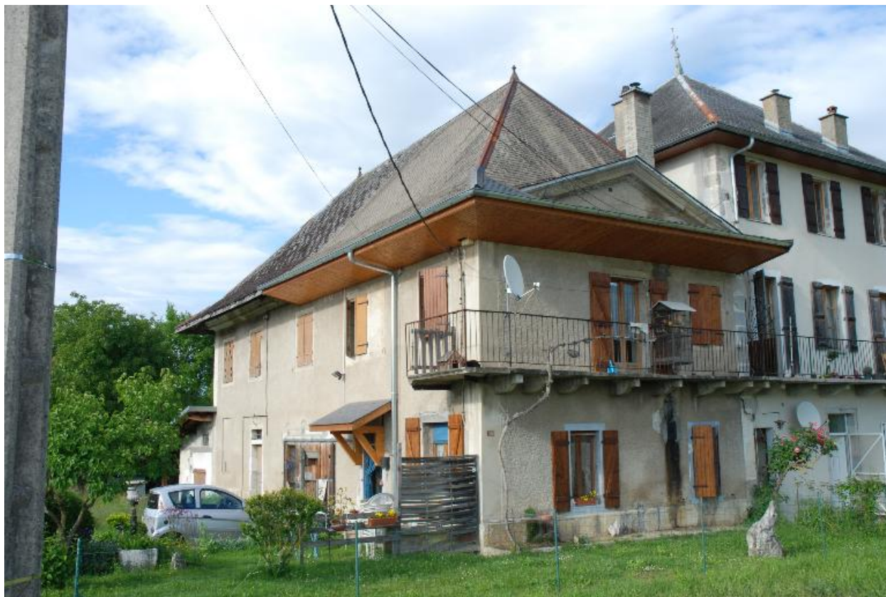
Bâtiment ouest, vue depuis le sud-ouest.
