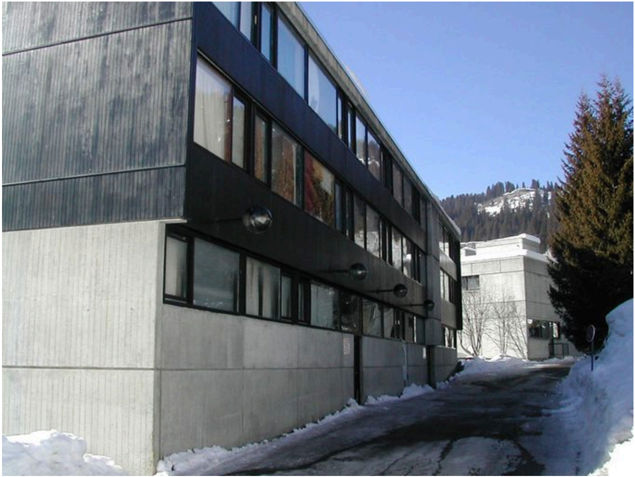
Façade nord, vue depuis l'est
