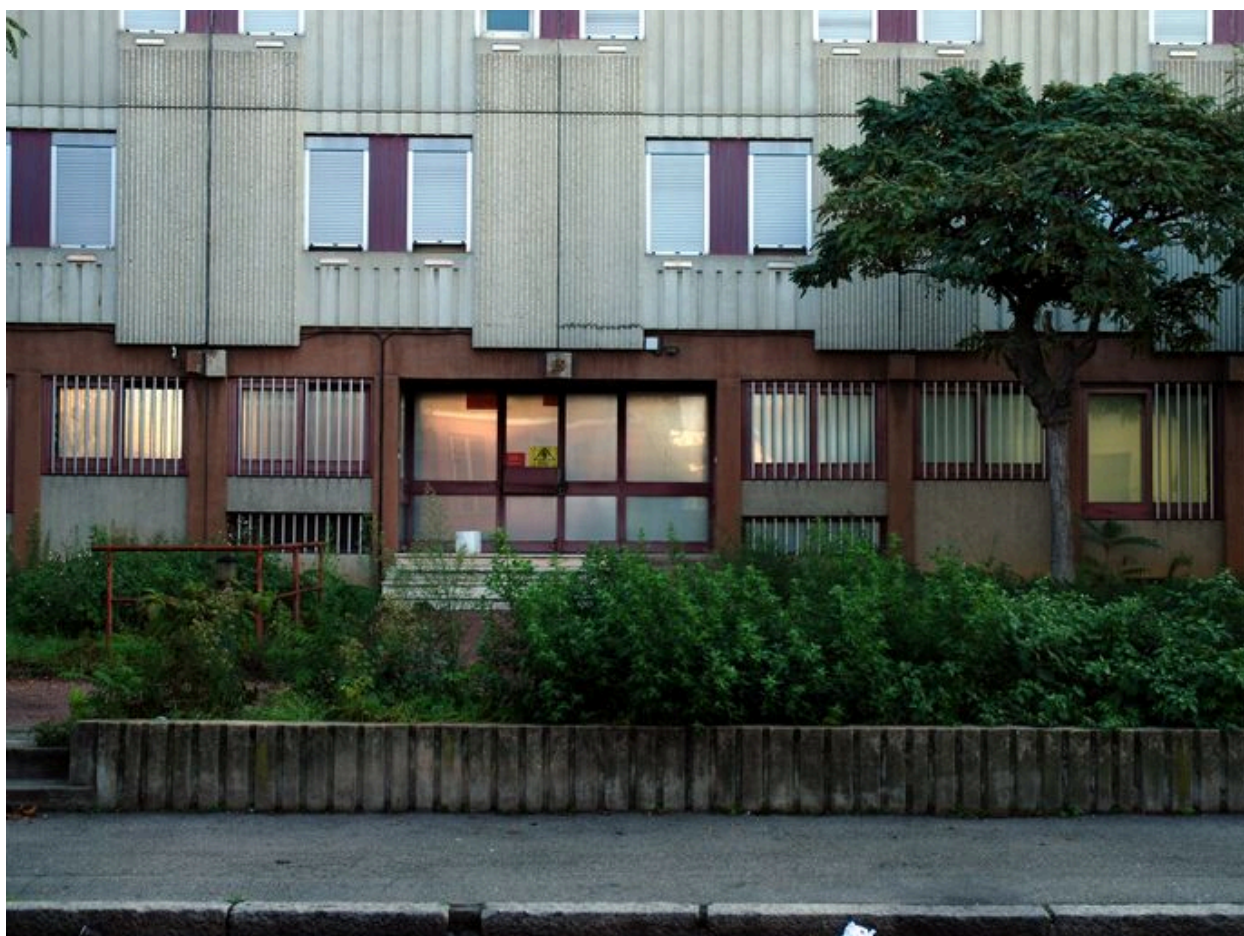
Détail de l'entrée.
