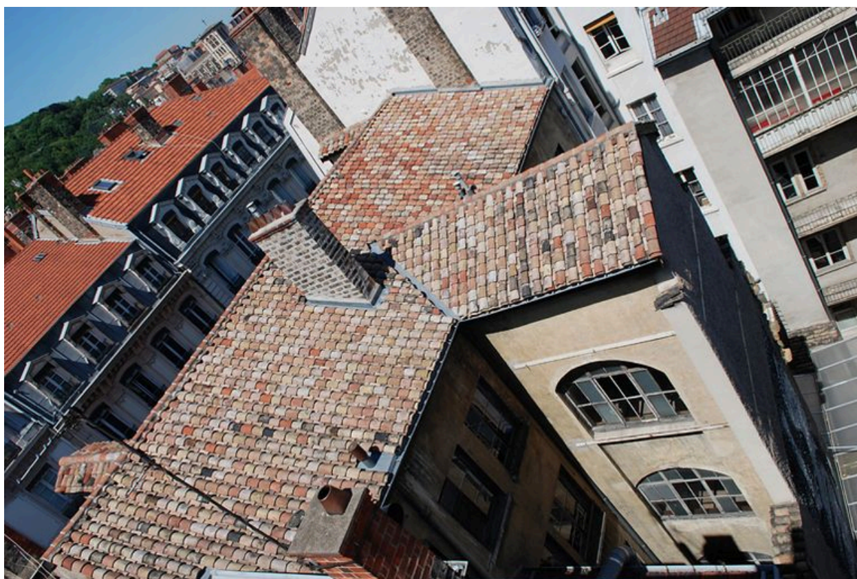
Vue de la toiture
