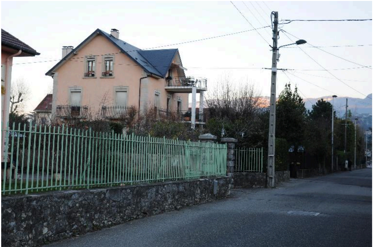
Vue d'ensemble : pignon ouest et façade sud
