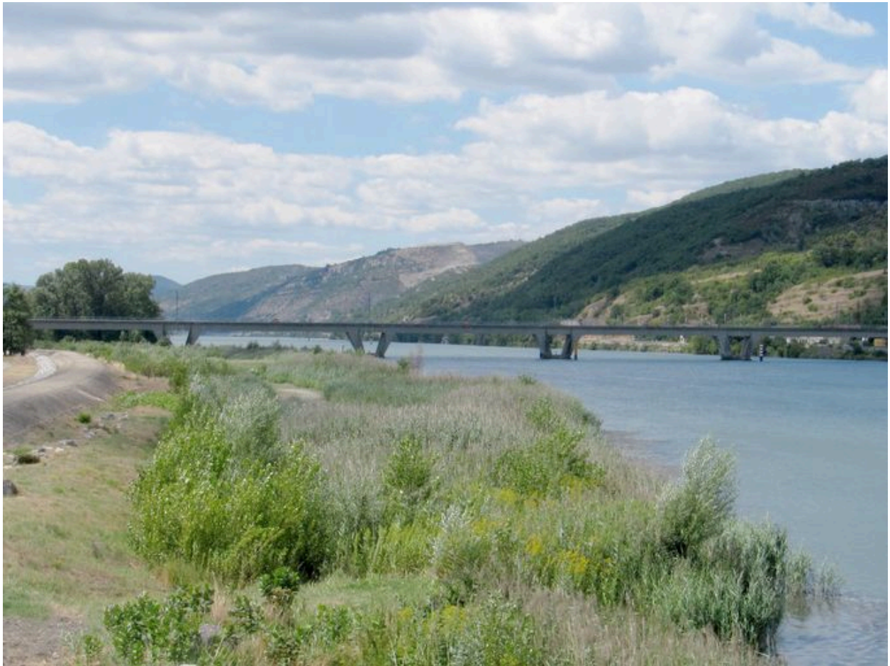
Vue générale, face amont (depuis le pont suspendu)
