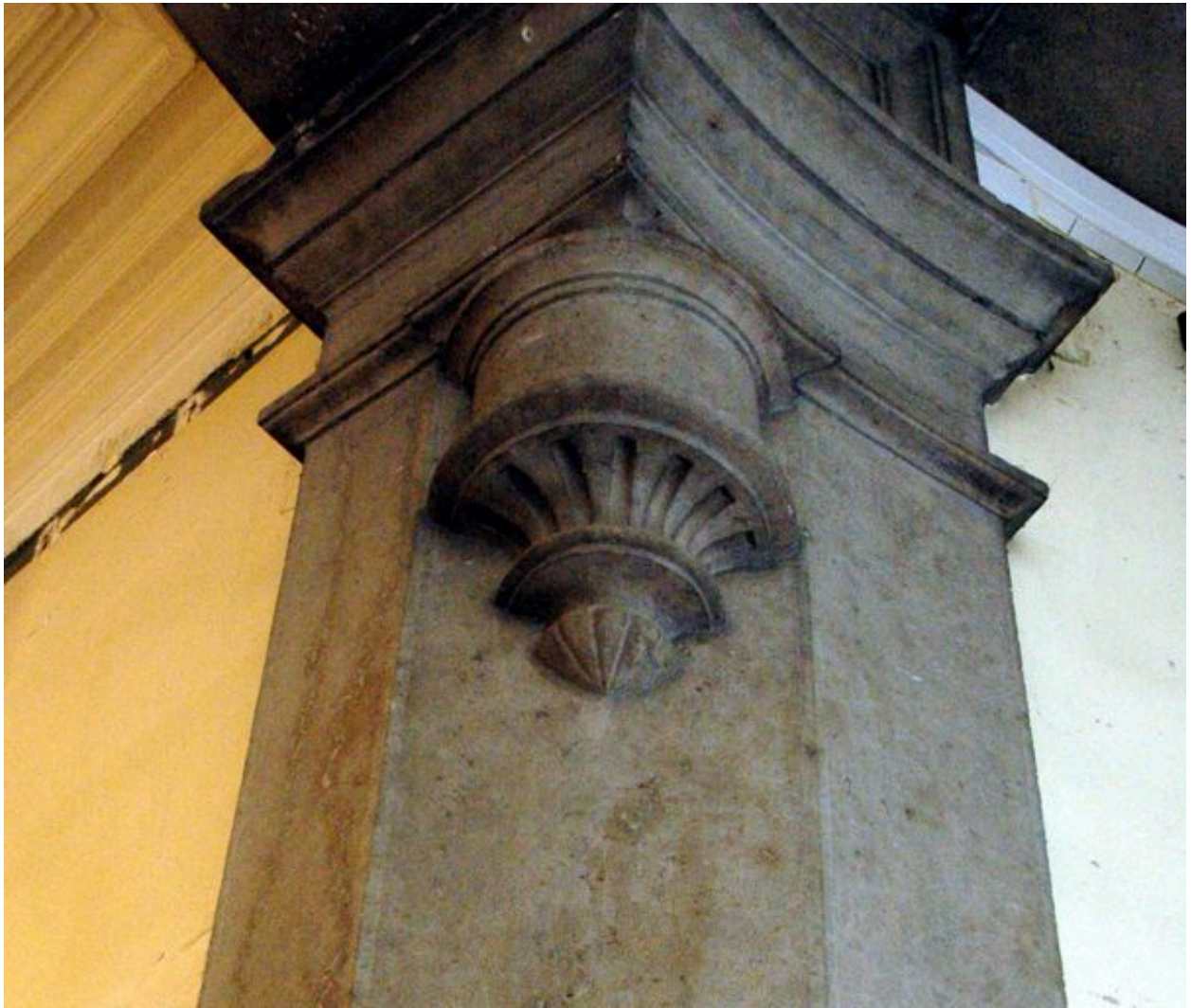
Arcade ouvrant sur la cage d'escalier : détail d'un culot supportant un chapiteau
