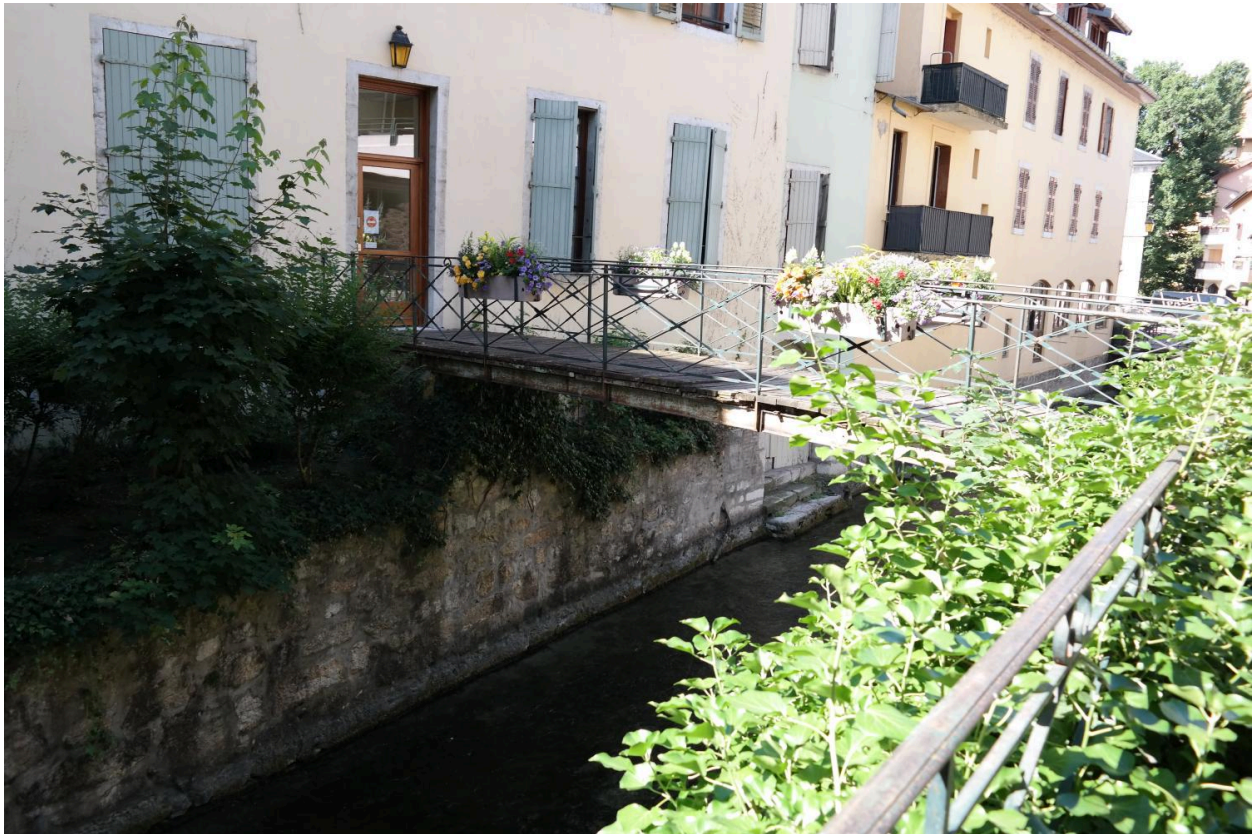
Passerelle des Cordeliers, vue de la face amont
