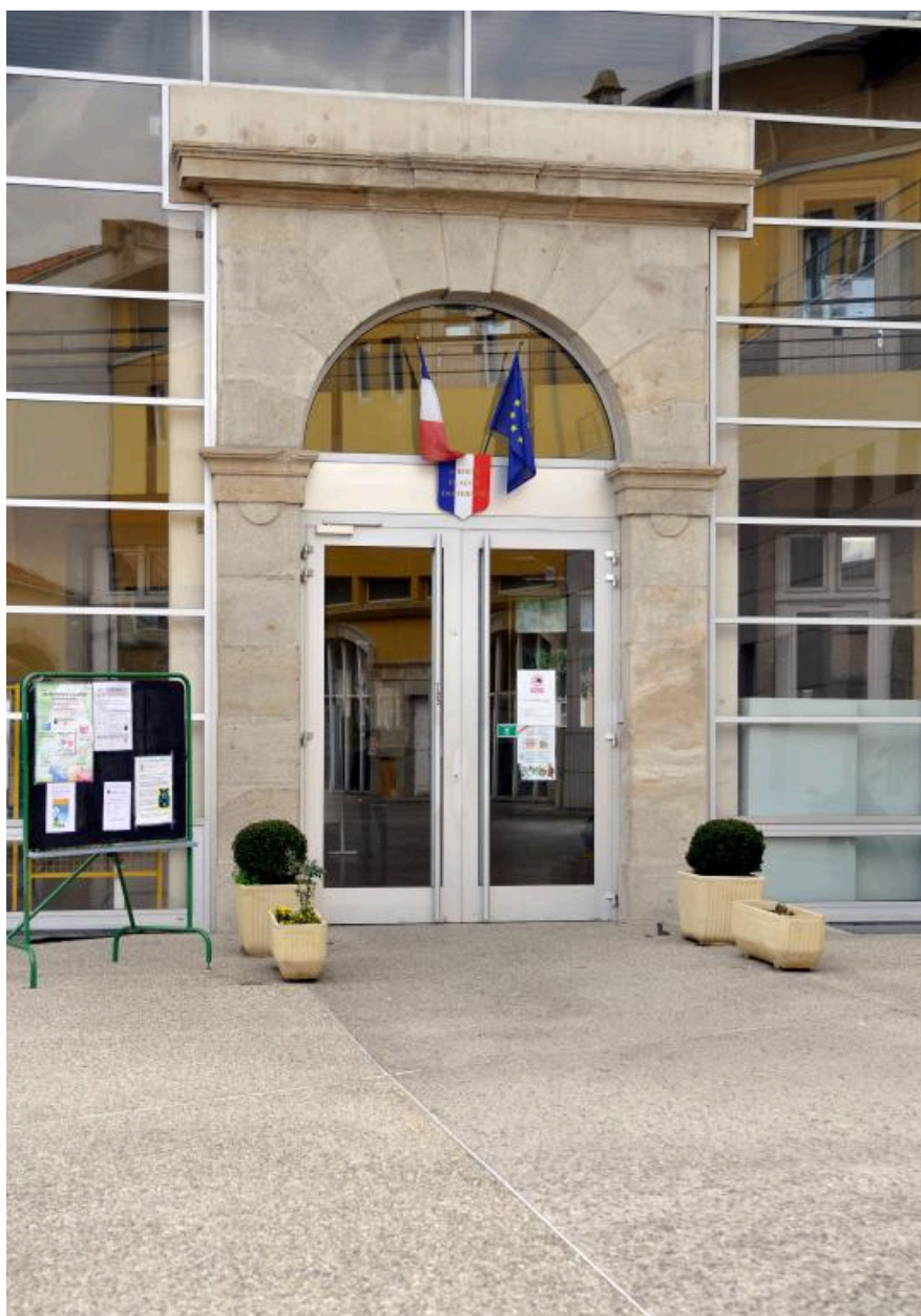
Porte d'entrée du collège sur cour 1
