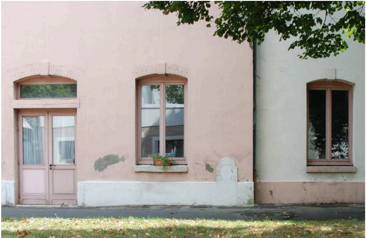
Ancienne boulangerie, façade principale (ouest), trace d'un point d'eau
