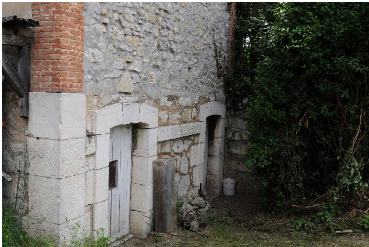
Portes dans le pignon sud
