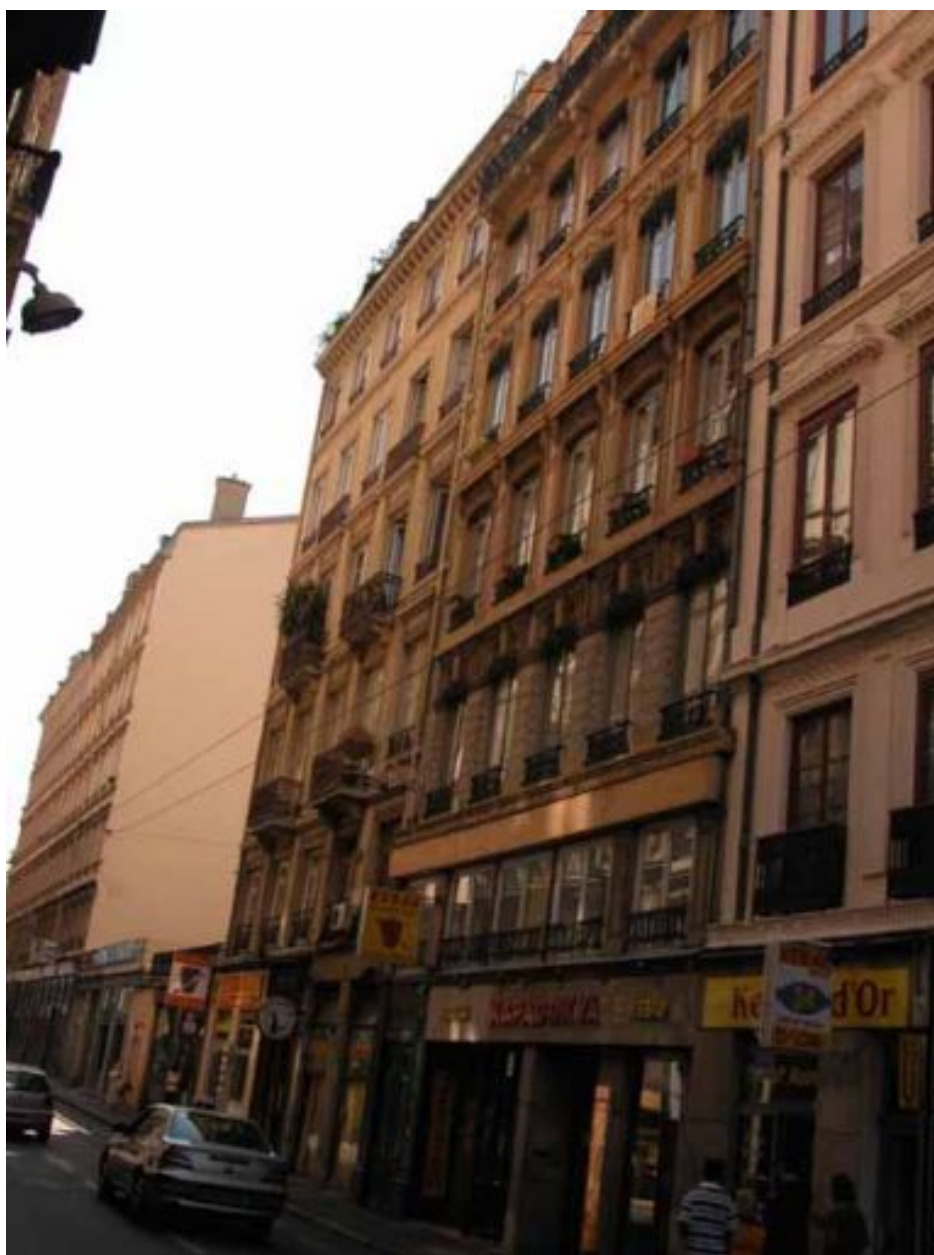
Façade sur rue, vue générale
