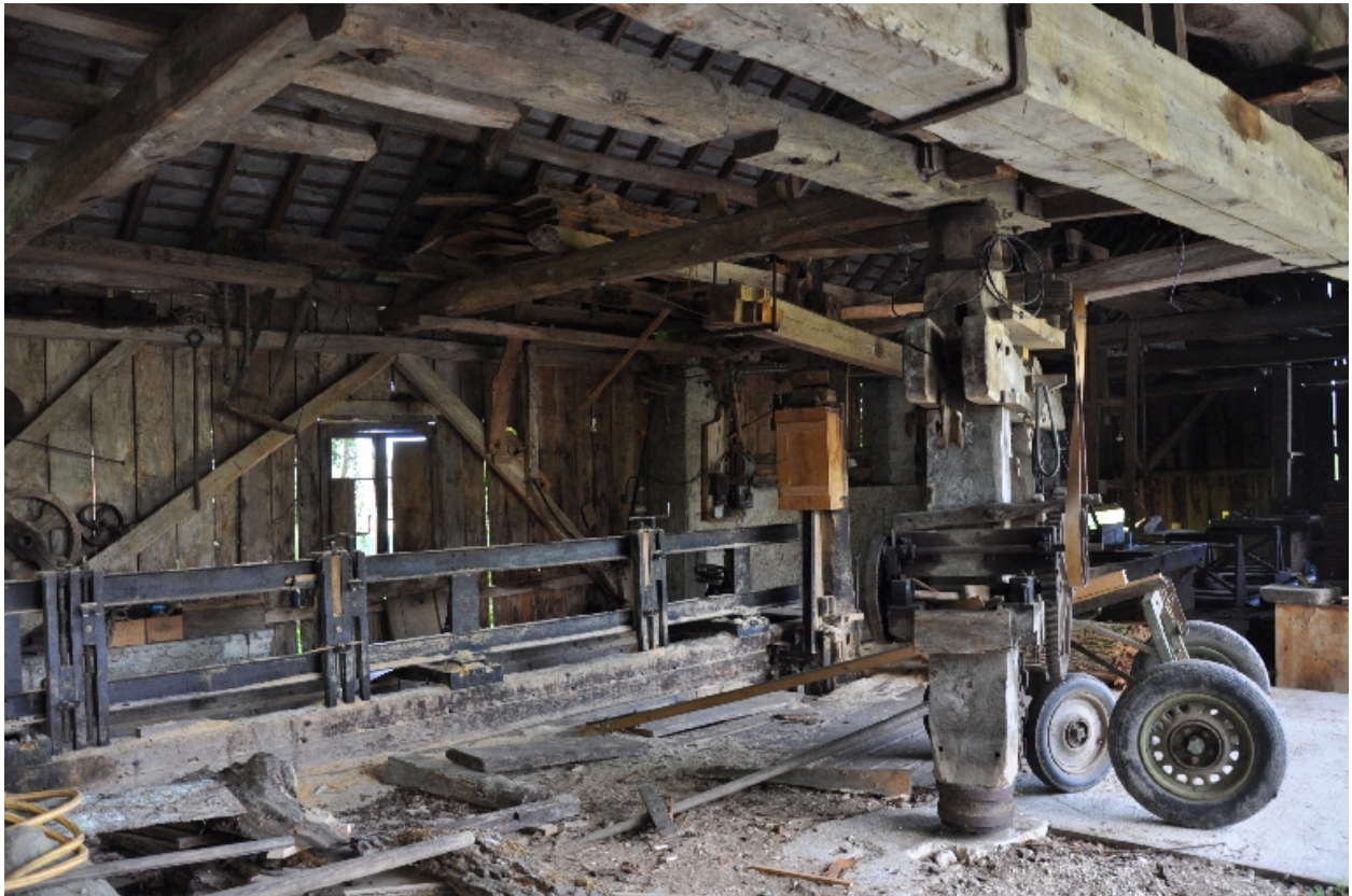
Vue générale de la scierie
