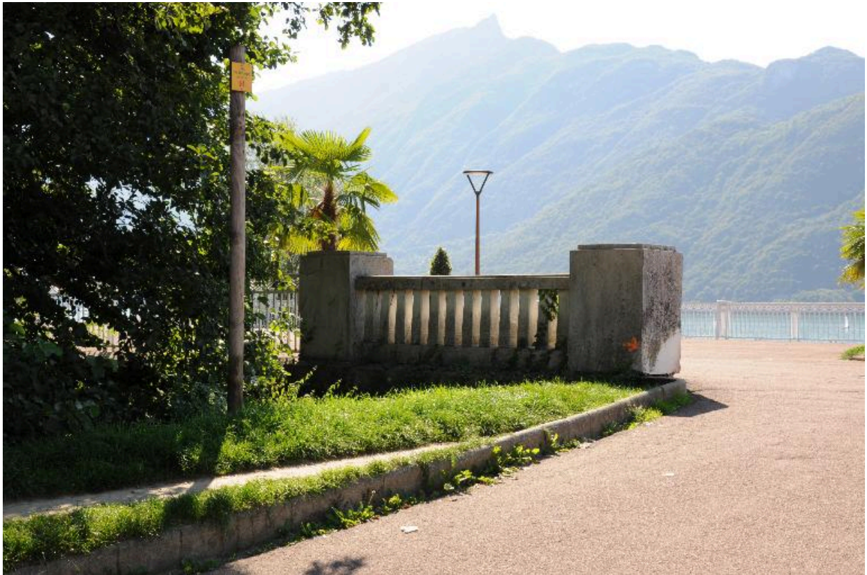
Pont sur le Sierroz : garde-corps en ciment
