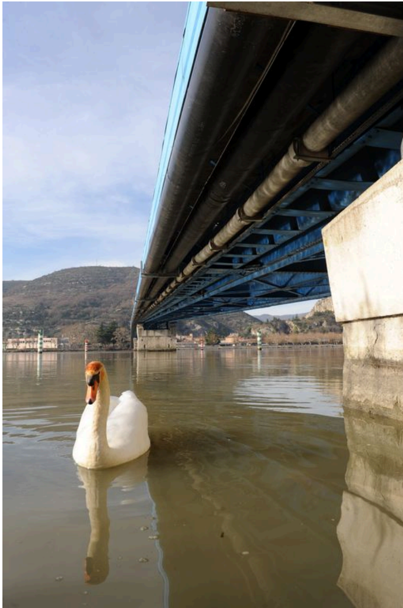
Vue partielle, de dessous, tablier et pile (depuis la rive gauche)
