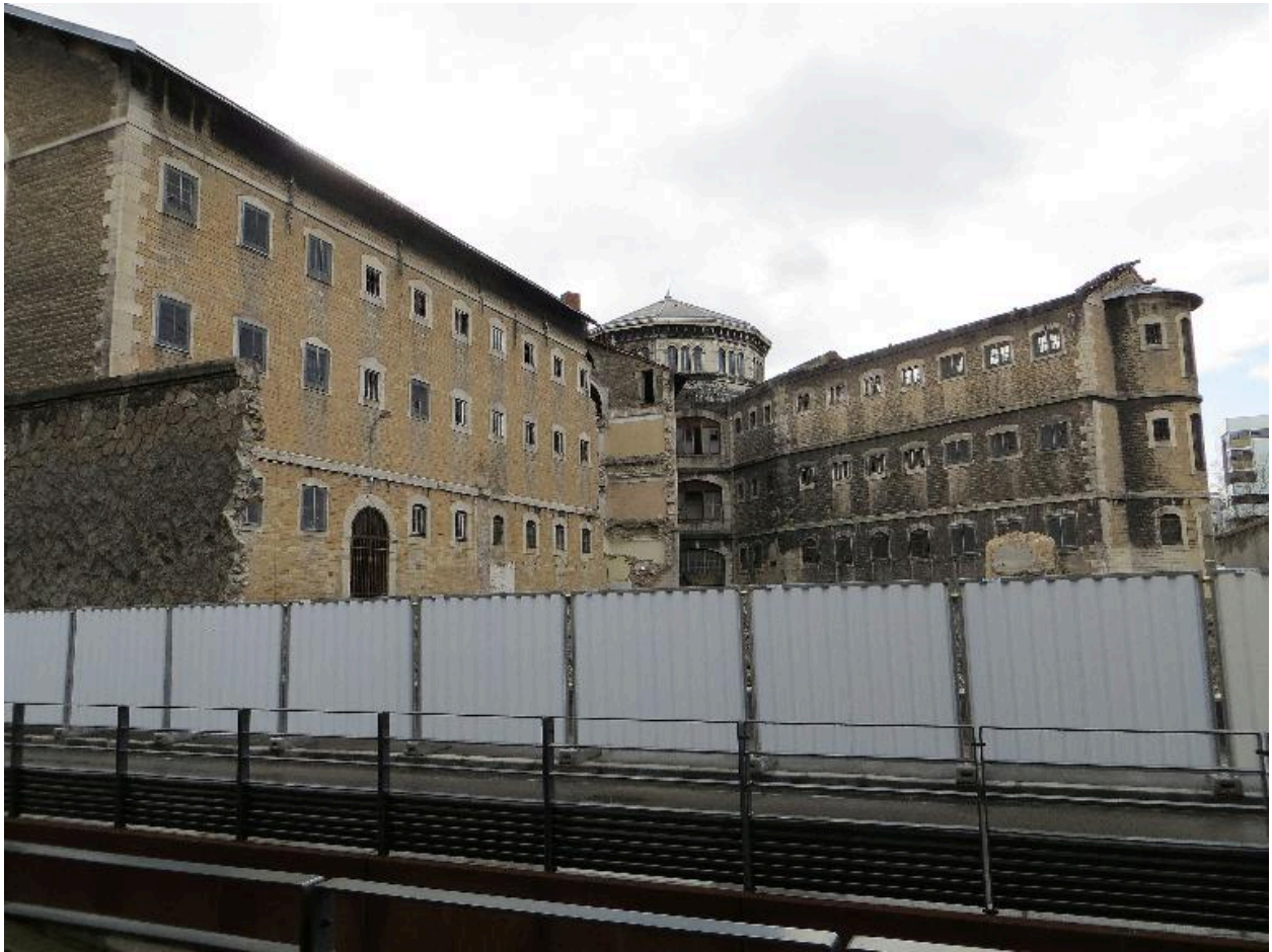
Etat au 7 février 2013 : les ailes nord et nord-ouest, la chapelle
