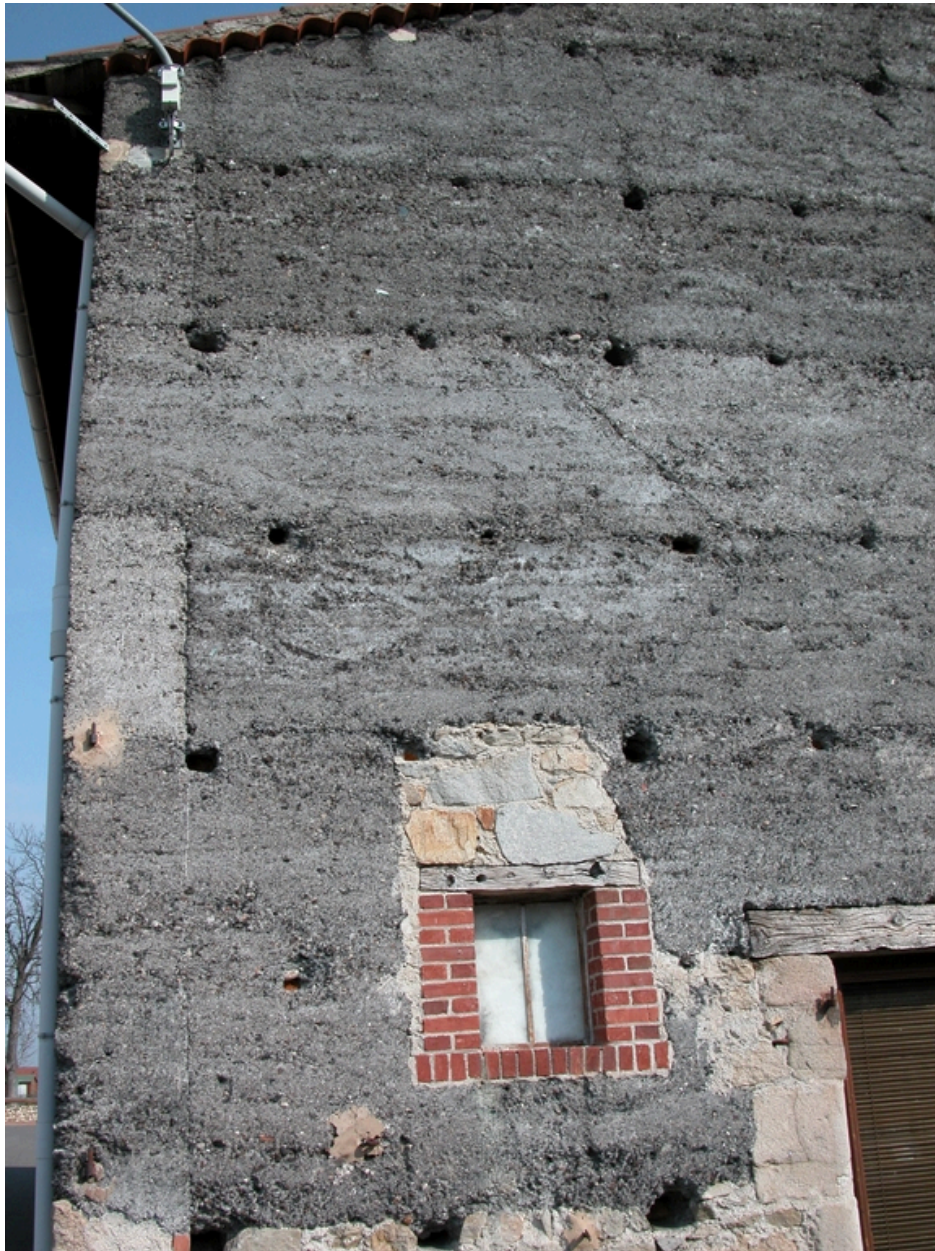
Grange-étable isolée à Crémérieux (1997 AS 17). Mur en pisé de mâchefer.
