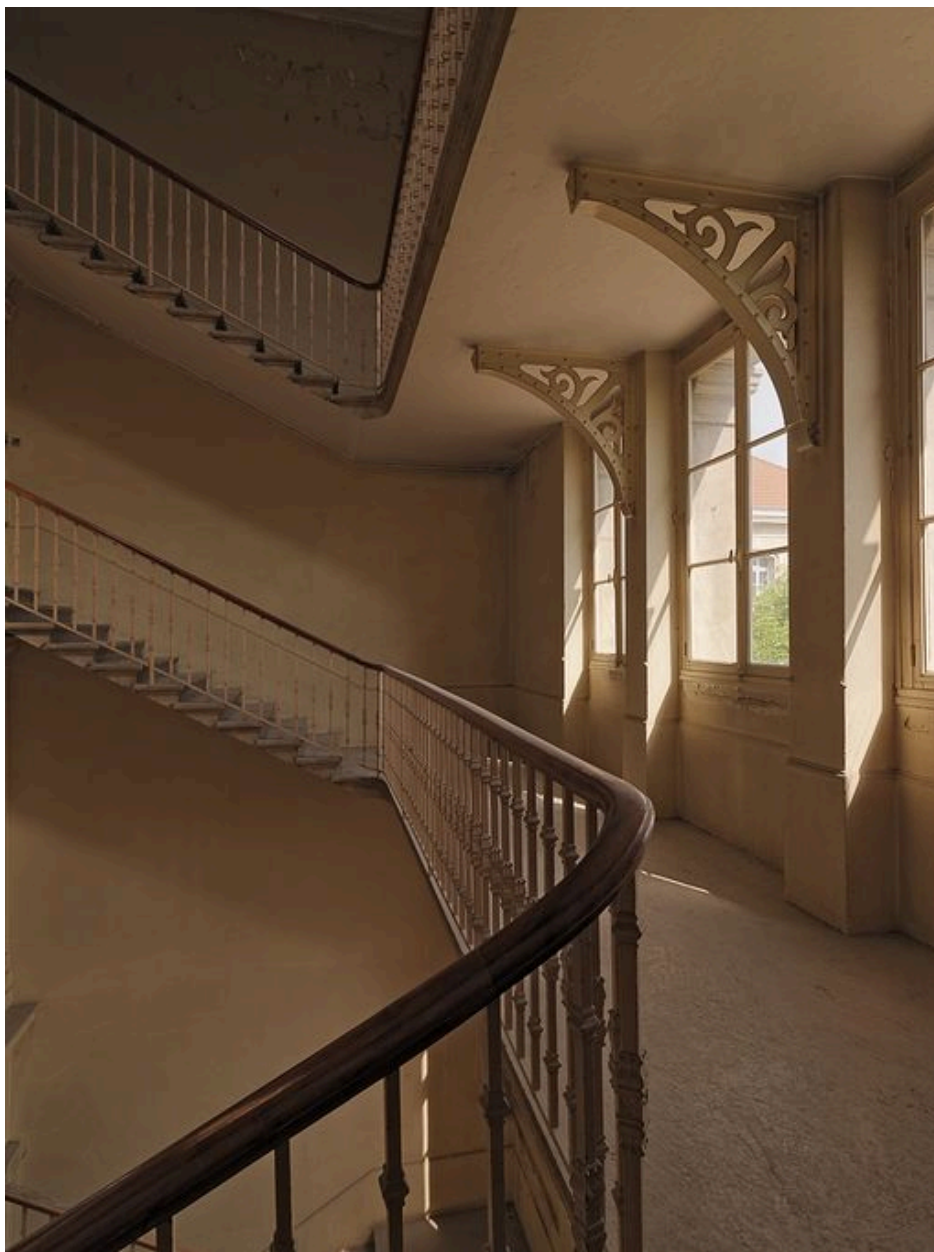
Détail du palier sous les combles.
