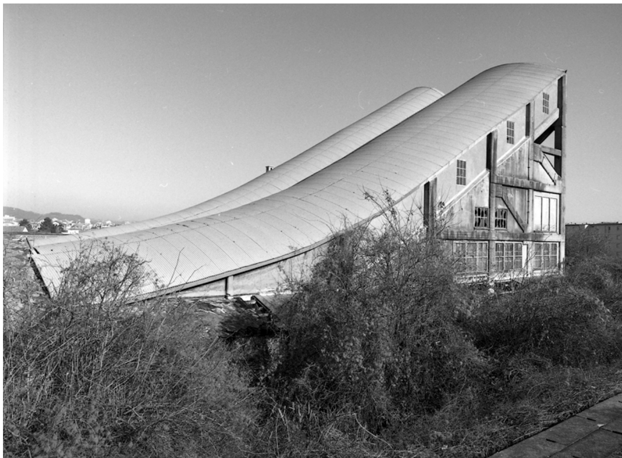
Pistes d'essais en 2005, avant destruction.
