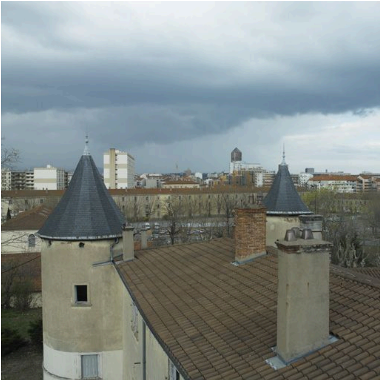
Corps de bâtiment ouest et tours nord-ouest et nord. Vue des toits depuis le sud
