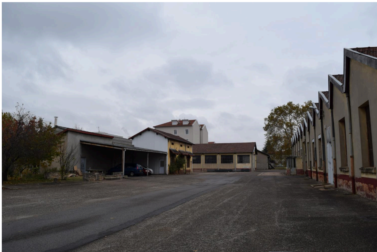
Vue des ateliers avant démolition
