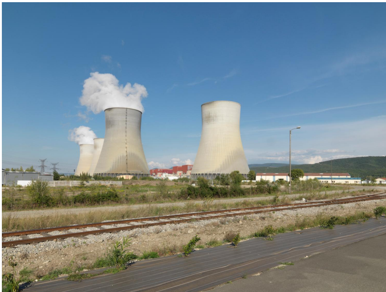
Tours de refroidissement
