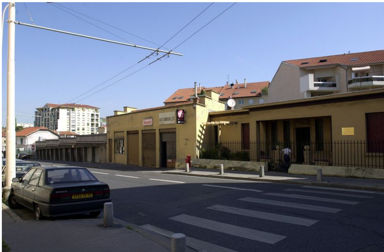
Vue générale sur la rue de Belfort
