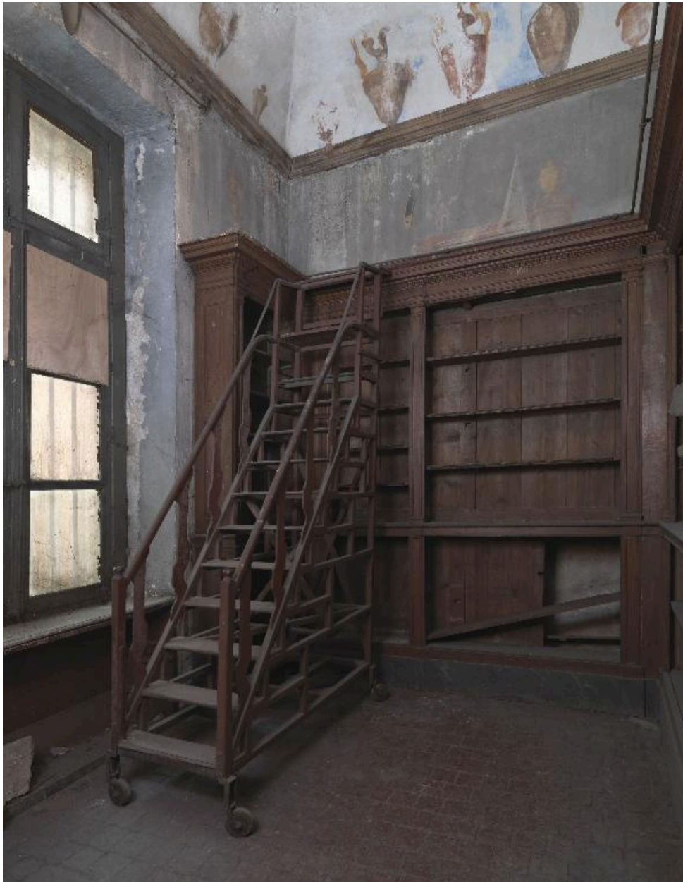
Vue d'ensemble, murs sud et ouest
