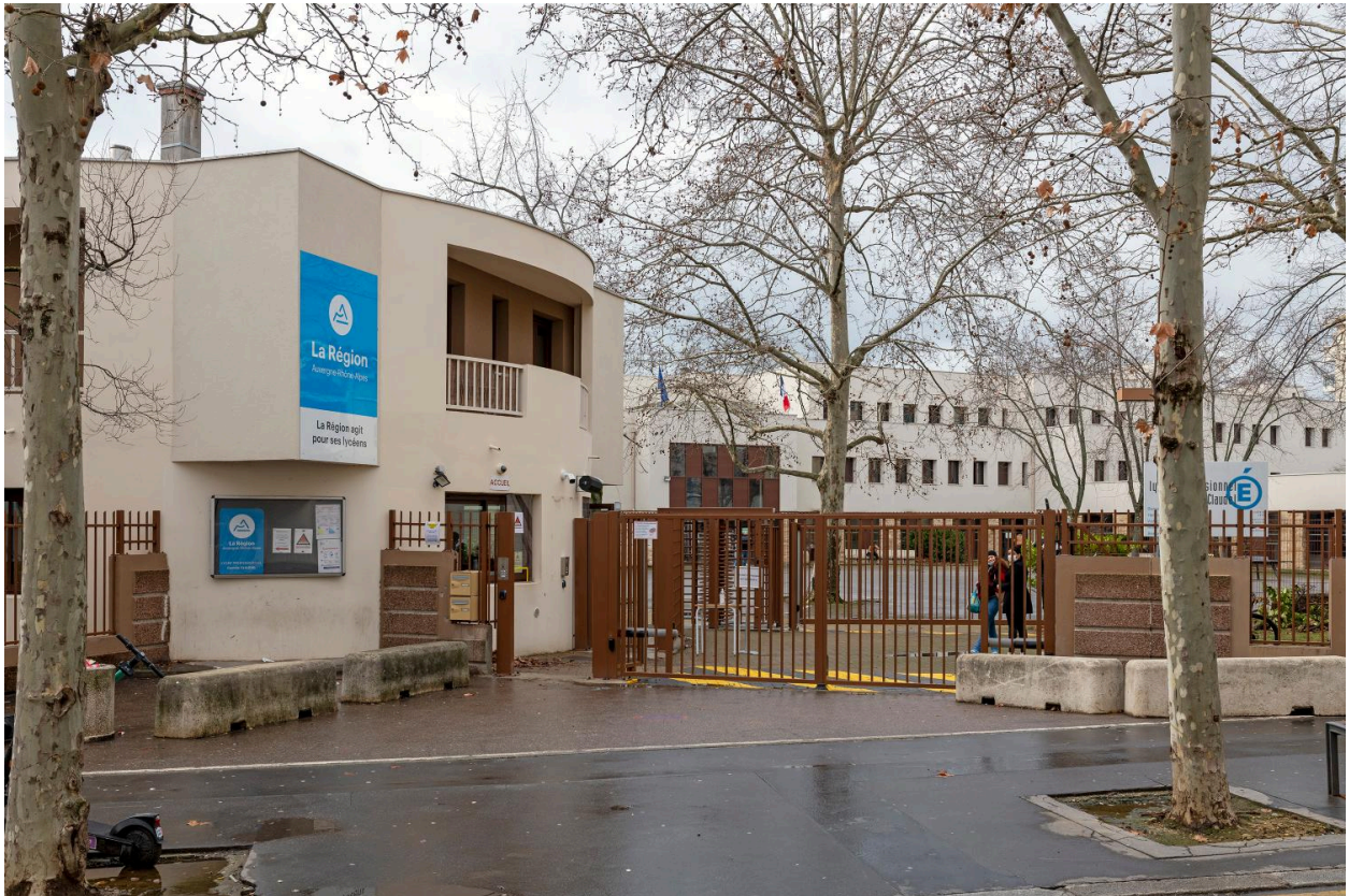
Vue du lycée depuis la rue.
