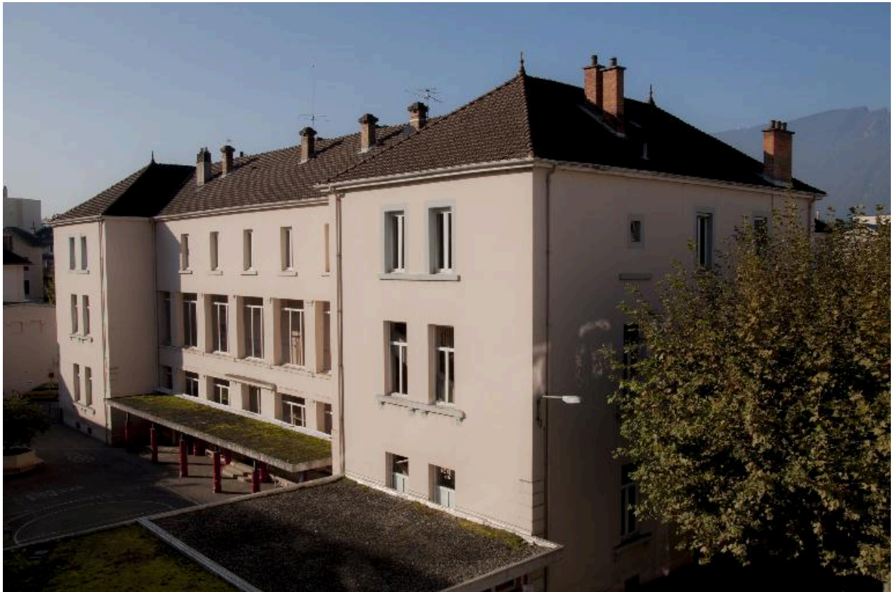
Vue d'ensemble : élévation postérieure
