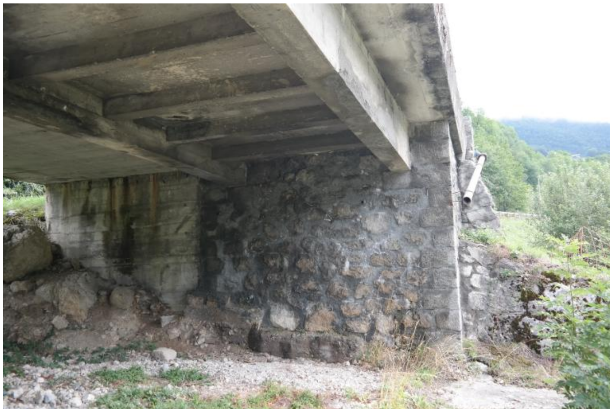
Pont de Fontanil, vue de dessous
