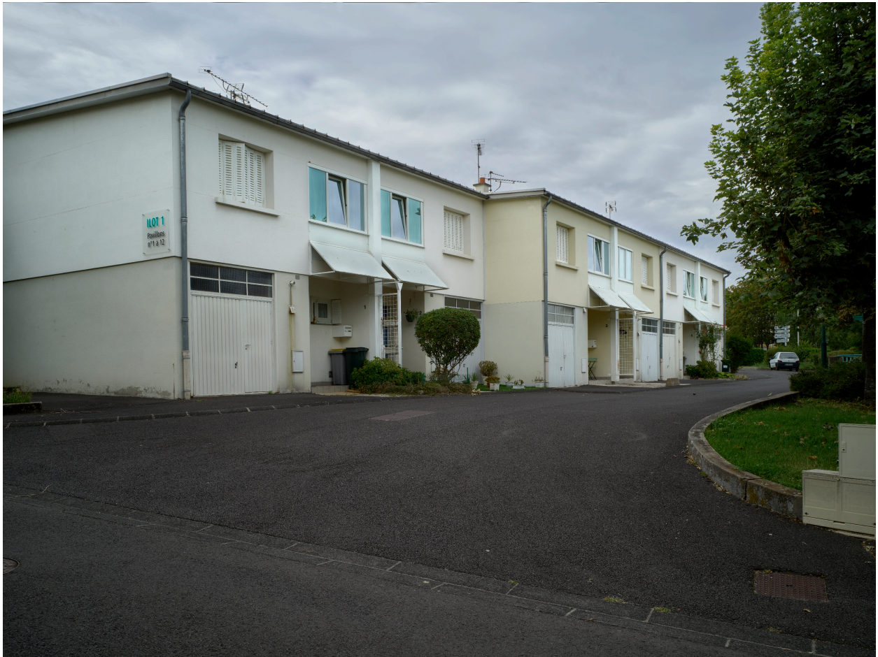
Maisons doubles accolées ayant donné son appellation au type "Bezance", cité de Romagnat (entre 1960 et 1962).
